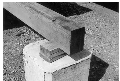
Figure 3: exemple de surface d'appui adaptée pour les piles de bois.
