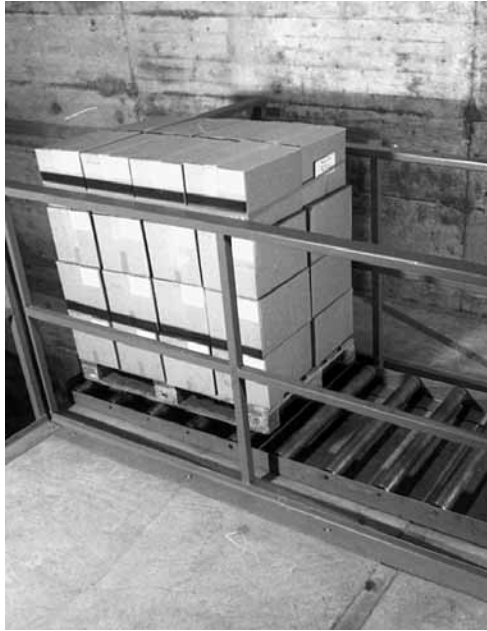
Bild 8: Mit der Rollenbahn ist der Zutritt zur Sturzstelle erschwert. Es kann auch hohes Lagergut übergeben werden. Bei der äussersten Rolle ist mit einem Anschlag zu verhindern, dass die Palette über die Rollenbahn hinausfahren und abstürzen kann.
