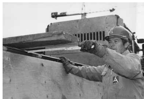
Figure 5: contrôle du gabarit de chargement avant le départ.
